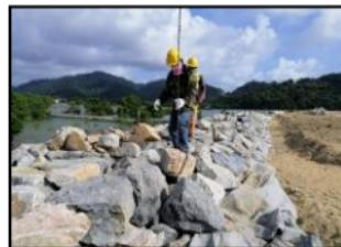
Kerja-kerja memasang 'Primary Rock' dari CH1200 ke CH1080 di 'Bank'
