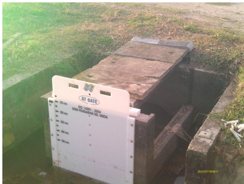
Gambarajah 2 : Struktur AT-GATE yang telah siap dipasang
