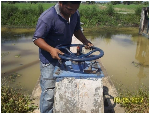
Struktur lama mudah berkarat dan menyukarkan operasi
