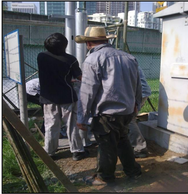
Gambar 5 : Menunjukkan kerja-kerja pemasangan tiang sedang dilakukan
