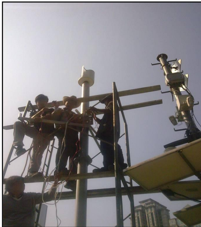
Gambar 6 : Menunjukkan kerja-kerja pemasangan wind turbine
