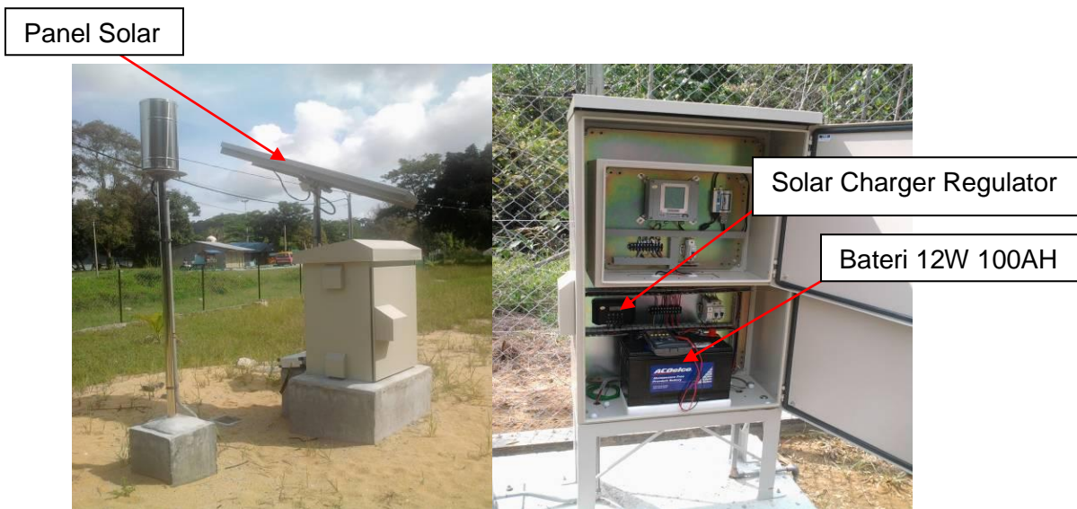
Gambar 3: Sistem bekalan kuasa yang dipasang di stesen telemetri
