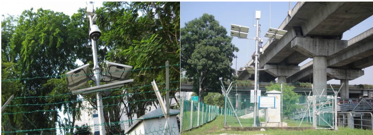
Gambar 1: Halangan daripada pokok dan deck slab fly-over yang menghalang pengecasan optimum oleh solar kepada sistem bekalan kuasa di stesen telemetri
