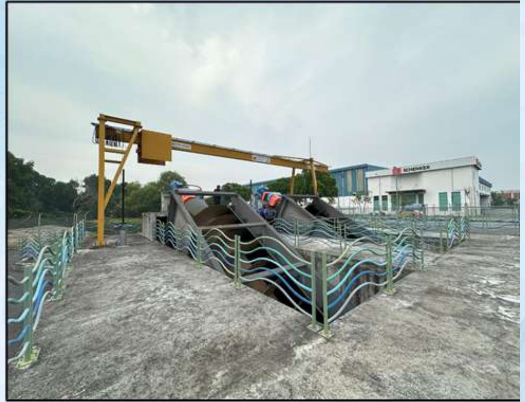
Gambar 2: Rumah Pam Taman Iping 1, Barat Daya, Pulau Pinang
