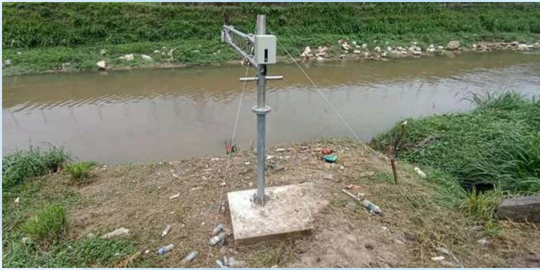
Gambar 1: Stesen Aras Air di Sg Gombak, Kampung Padang Balang
