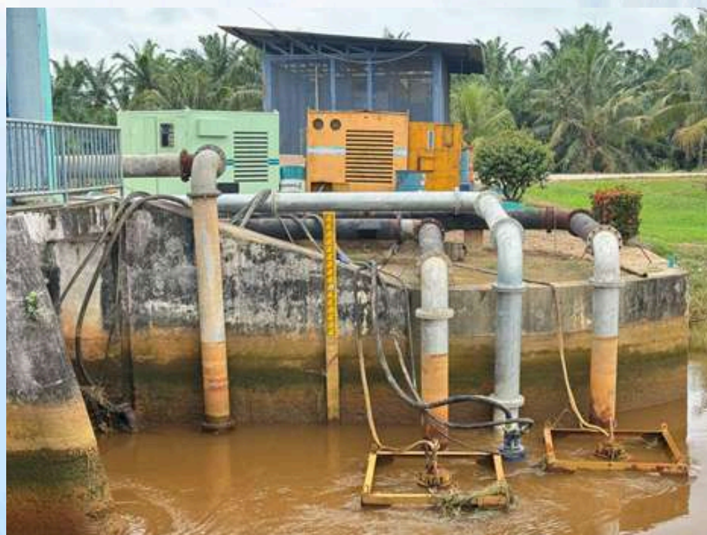
Pemasangan Pam NADMA di Negeri Johor
