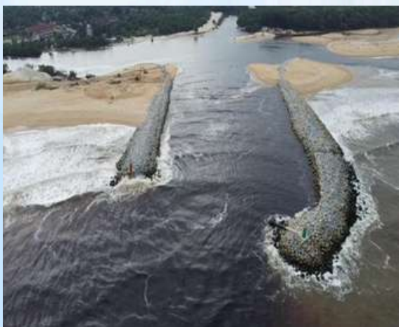
Gambar 5: Struktur pemecah ombak yang telah siap
