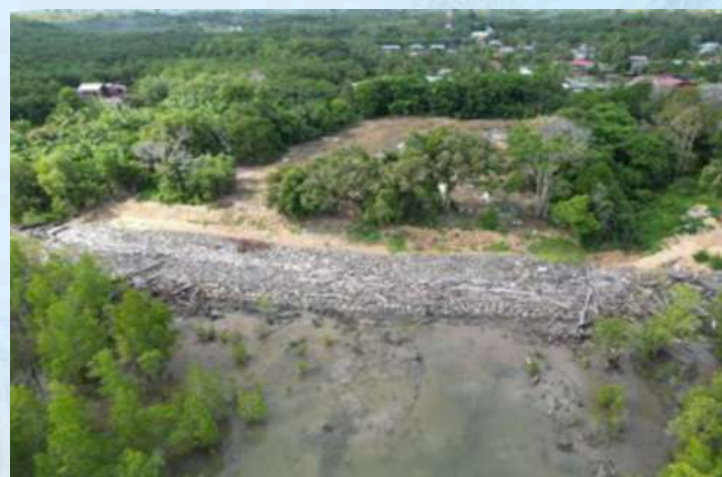
Gambar 3 : Pembinaan Rock Revertment yang telah siap di kawasan Kg. Tamang
