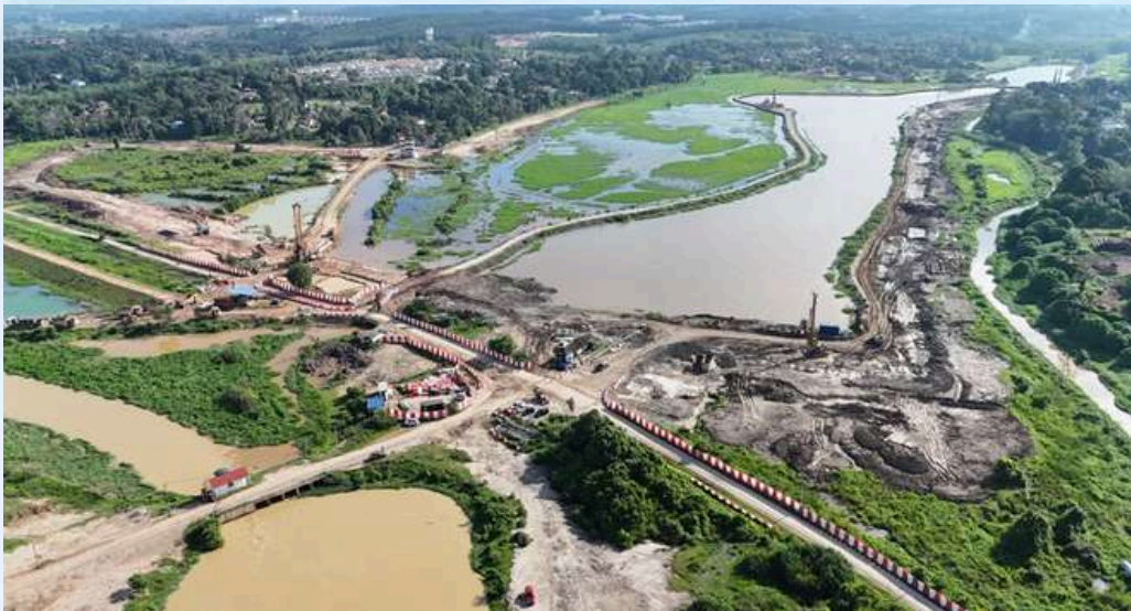
Pandangan Udara Kolam Durian Tunggal dan Kerja-Kerja WSM di Tapak
