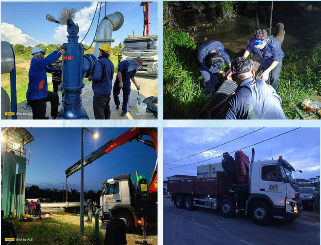
Gambar Pemasangan Pam
