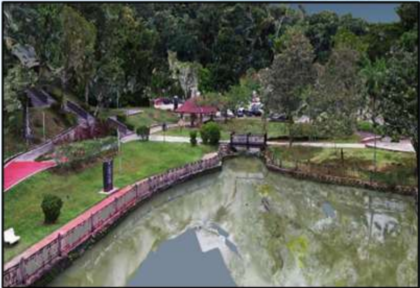
KERJA-KERJA DESILTING KOLAM, SUNGAI SERTA KERJA MEMBAIKPULIH STRUKTUR DAN KERJA- KERJA BERKAITAN DI TAMAN PERSEKUTUAN BUKIT KIARA, KUALA LUMPUR
