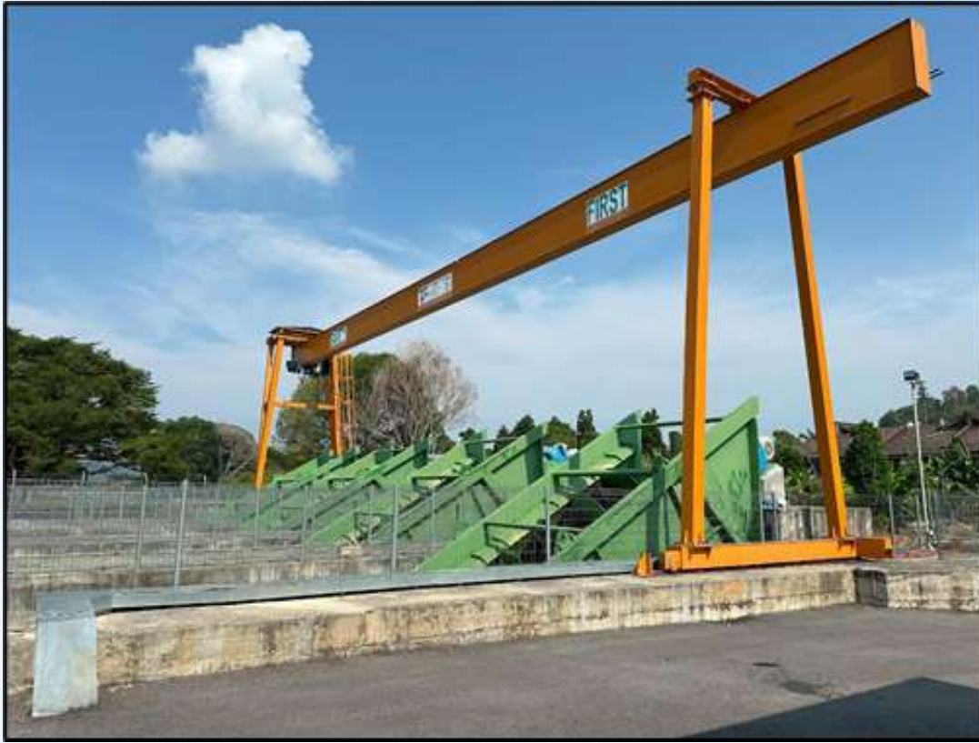
Gambar 1: Rumah Pam Bayan Baru, Barat Daya, Pulau Pinang
