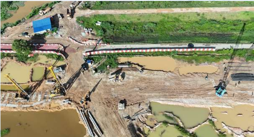
Pandangan Udara Kerja-Kerja Bored Pile di Tapak
