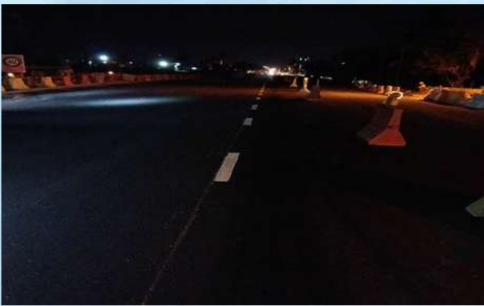
Seribong Main Drain – Kerja-Kerja Premix Crossing Seribong CH1390 (Hadapan Projek Bangunan Gunasama Tunjung)
