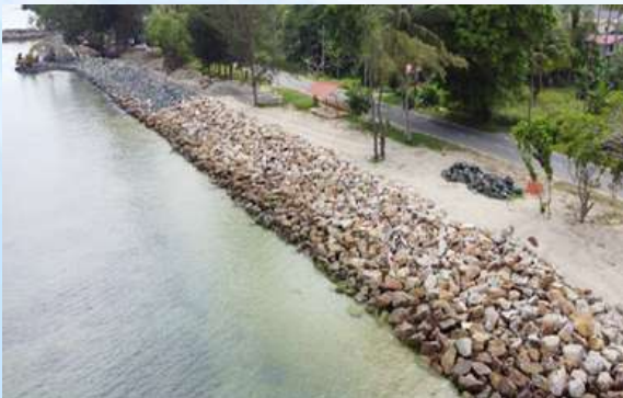
Gambar 10 : Pembinaan Struktur Rok Revetment yang telah siap sebelum kerja Beach Nourishment dilaksanakan
