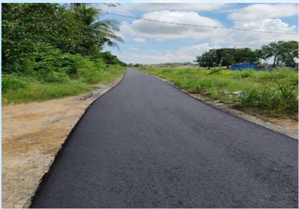
Seribong Main Drain – Kerja-Kerja Premix Crossing Seribong CH 1390 (Hadapan Projek Bangunan Gunasama Tunjung)
