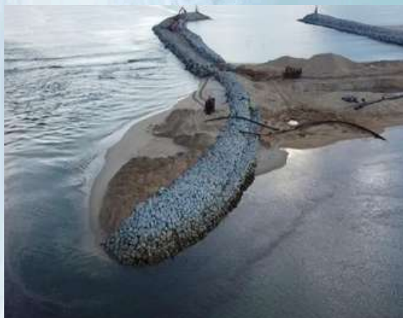
Gambar 3: Pembinaan struktur pemecah ombak
