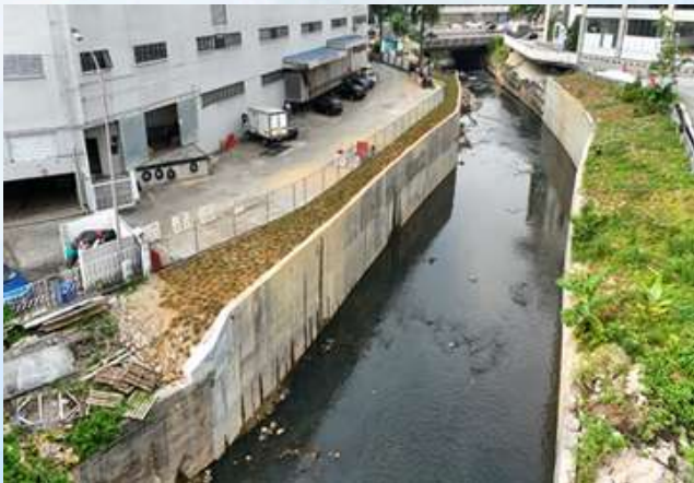
KERJA-KERJA PENGUKUHAN TEBING SG. PENCHALA BERHAMPIRAN BANGUNAN AVON JALAN 51A/219 PETALING JAYA DAN KERJA-KERJA BEKAITAN BAGI MENGURANGKAN RISIKO BANJIR DI DAERAH PETALING, SELANGOR DARUL EHSAN
