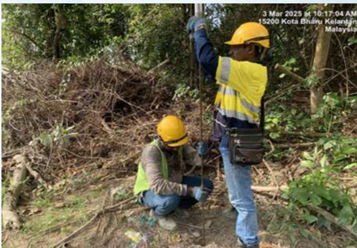
Mackintosh Probe Test Di Kawasan Penambahbaikan Longkang S8 – Kg Baung Bayam
