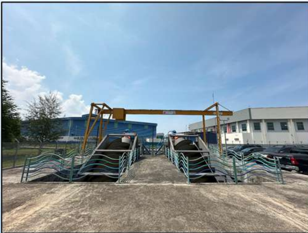
Gambar 3: Rumah Pam Taman Iping 2, Barat Daya, Pulau Pinang
