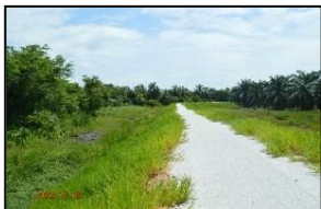
Pembinaan Ban di CH 8300 – CH11000
