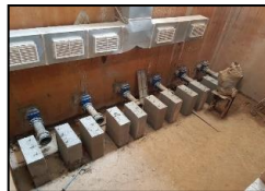
Kerja-kerja pemasangan pam dan Sistem pembentungan
