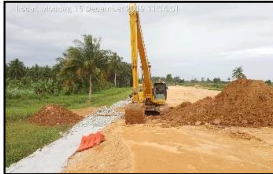
Pembinaan Flood Levee di Ch 5025 Kg Gerong
