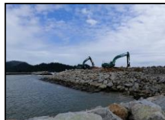
Meratakan aras 'Core Rock' dari CH200 ke CH180 di Kawasan kepala T-Groyne 3
