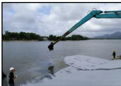
Kerja-kerja pemasangan geotextile panel BPR12 di Bank Protection
