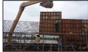
Pembinaan floodwall di Kg Laut CH8877-CH8853
