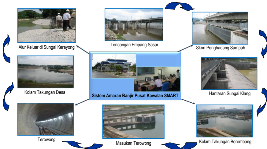
Gambarajah 8.3: Komponenan Aliran Operasi Banjir SMART
