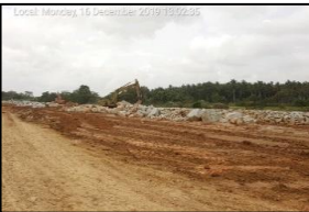
Pembinaan Flood Levee di Kg. Sg. Tikat
