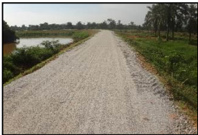
Pembinaan Ban CH 6500
