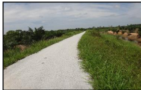
Pembinaan Ban di CH 13000
