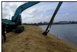
Meratakan cerun pasir di CH170-CH150
