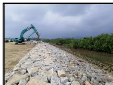
primary rock' dari CH1080 ke CH1060 yang telah siap dipasang dibahagian Bank Protection
