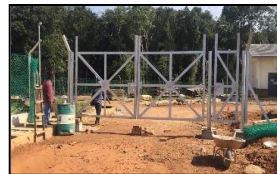
Pemasangan pagar Rumah Pam
