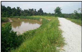
Pembinaan ban CH 9000-13000
