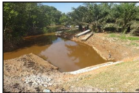
Box Culvert CH 7650
