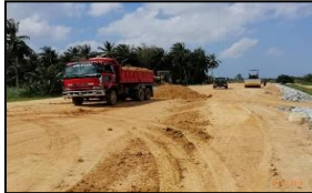
Kerja-kerja tambun tanah dan pepadatan di Kg. Gerong CH5300-CH5480
