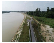
Pembinaan Ban/Benteng Bandar Pekan
