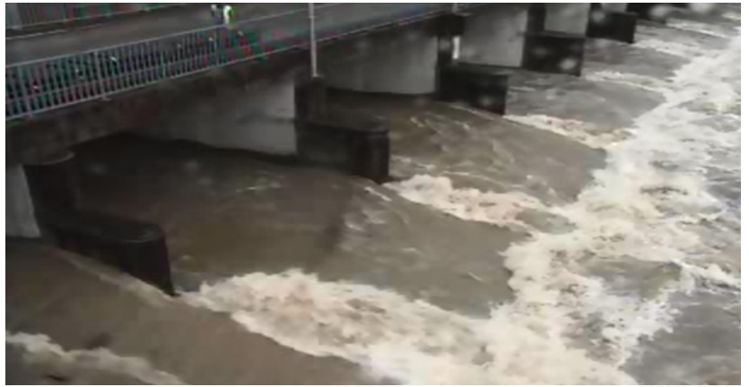
Gambar 2 : Keadaan di struktur Lencongan (L5) semasa Mod 3 diaktifkan pada 18 November 2017 ( 30.38\text{m}^3/\text{s} )
