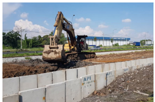
Kerja-kerja Pembinaan U-Drain
