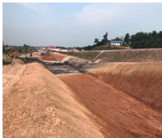
Penggalian Sungai di CH2200-CH3800 R2
