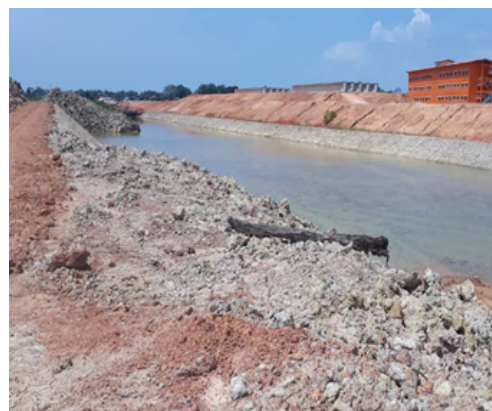
Penggalian Sungai di CH3800-CH4000 R2
