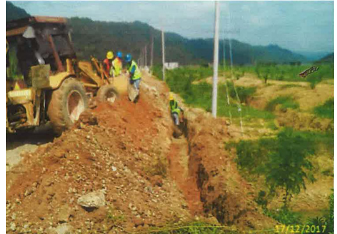
Sambungan Kerja-kerja Lay Cable Dari Jalan Utama ke Pintu Utama Pond 2
