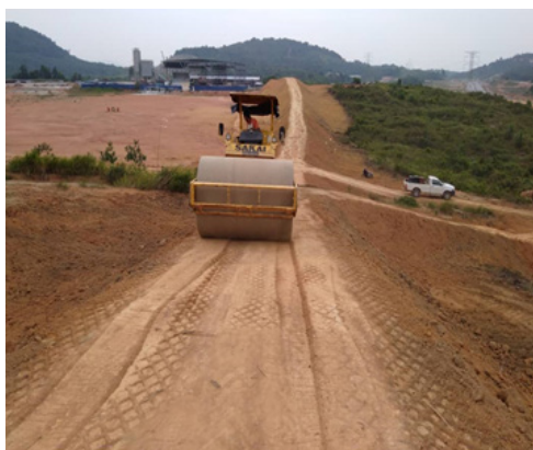
Pembinaan bund di CH3800-CH6100 R3
