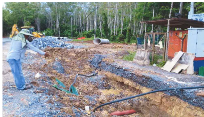
Pengalihan Cable Underground Di Hadapan TNB Sub Station di Jalan Sahabat – Kg Aman Untuk Beberapa Cable Underground Yang Lain
