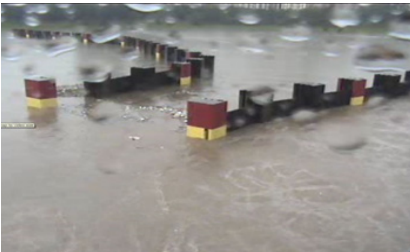
Gambar 3 : Keadaan Kolam Takungan Berembang semasa Mod 3 diaktifkan pada 18 November 2017 (34.83m dengan isipadu 690,246.18\text{ m}^3 )
