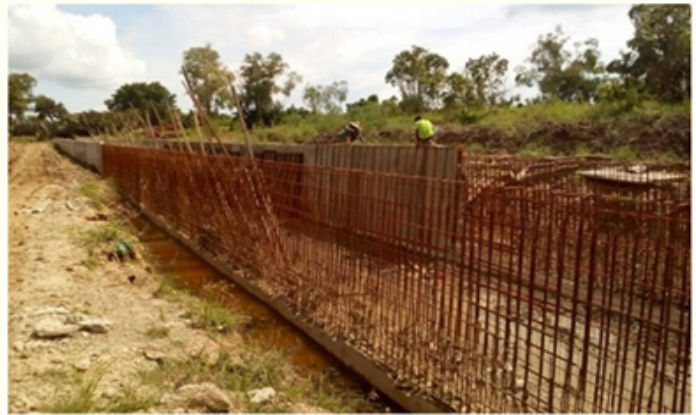
Kerja-kerja pemasangan Rebar Wall
