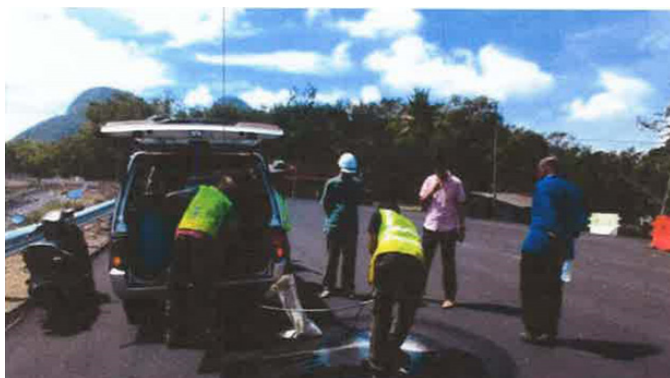
Coring Test di Jalan Sahabat – Kg Aman
