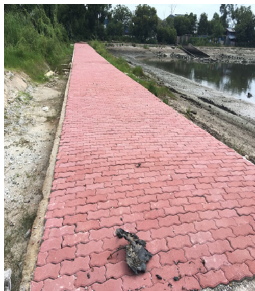
Kerja-kerja pembinaan U-Drain di Jalan Pelabuhan Klang Utara
