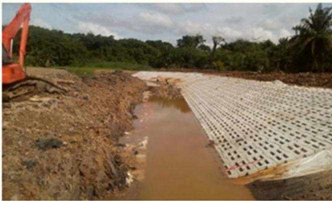
Kerja-kerja pemasangan Block Stone untuk MSMA Drain
