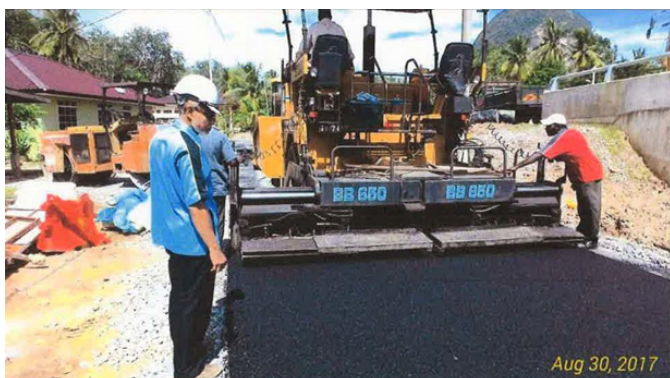
Kerja-kerja Premix Jalan Susur Keluar Di Jalan Sahabat – Kg Aman
