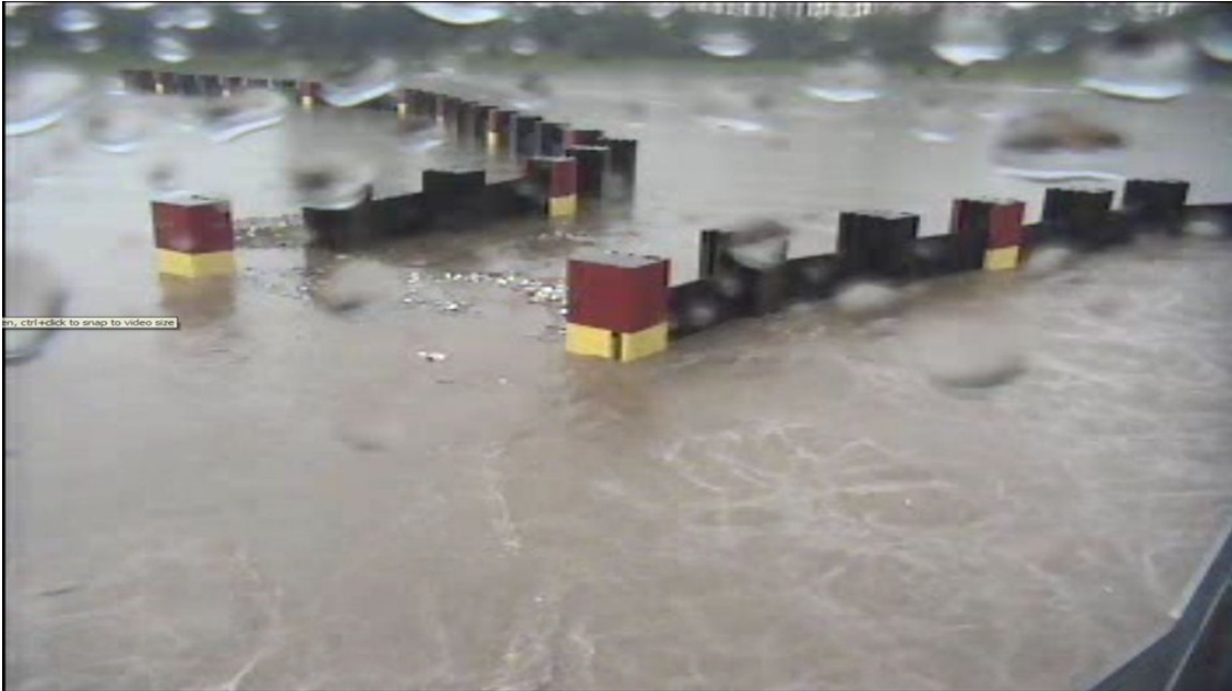
Aras air Kolam Takungan Berembang mencecah 35.06 m setelah 336,264.63 \text{ m}^3 air banjir disalurkan ketika berlaku kejadian Mod 2 pada 7 September 2015
