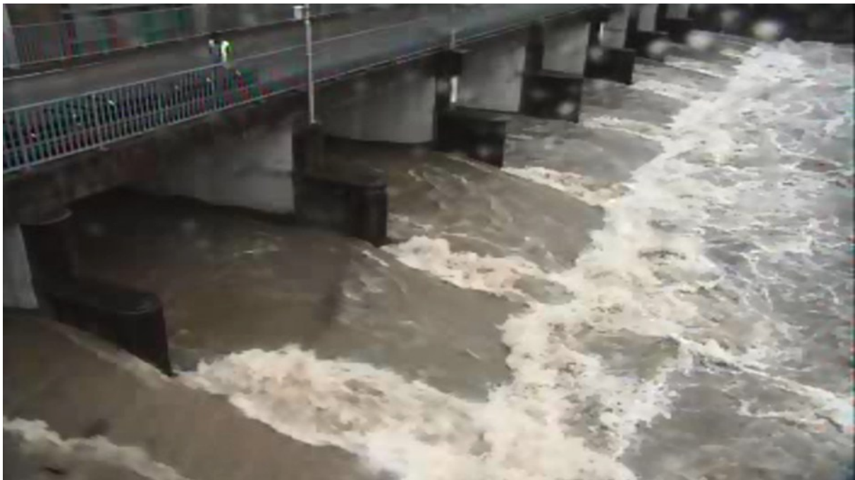
Kadaralir di L5 yang dilencongkan ke Kolam Takungan Berembang meningkat sehingga 93.98m 3 /s ketika berlaku kejadian Mod 2 pada 7 September 2015
