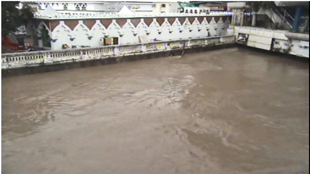
Aras air sungai di Jambatan Tun Perak mencecah 28.64 m ketika berlaku kejadian Mod 2 pada 7 September 2015
