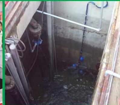
Interceptor system yang dipasang di tapak
