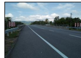
Jambatan Sg. Jarum
