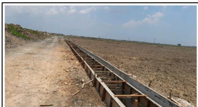
Caping Beam untuk U-drain (900mm x 900mm)
