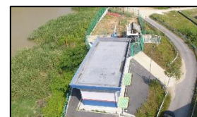
Aerial View Rumah Pam Bandar Baharu
