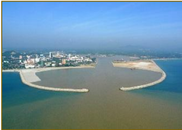
Pemecah Ombak Di Kuala Terengganu
