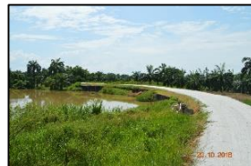
Permanent Steel Sheet Pile di CH16650
