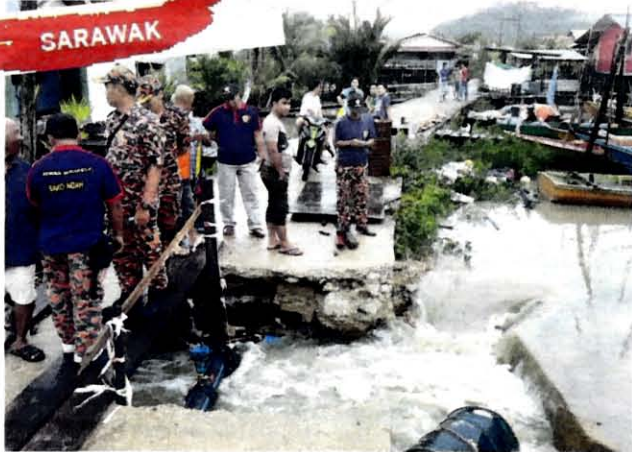
ANGGOTA bomba melakukan pemeriksaan ke atas benteng air yang pecah akibat fenomena air pasang besar di Kampung Bako, Kuching, Sarawak semalam.
