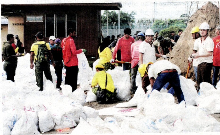
Agensi kerajaan, NGO dan penduduk setempat bekerjasama melakukan kerja-kerja meninggikan ban bagi menghadapi fenomena air pasang besar yang dijangka berlaku Ahad ini.
