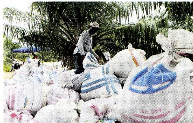
SUKARELAWAN Kampung Lembah, Tanjung Karang mengangkat guni pasir untuk diletakkan sepanjang benteng pemecah ombak di Pantai Sungai Kajang, Tanjung Karang.
