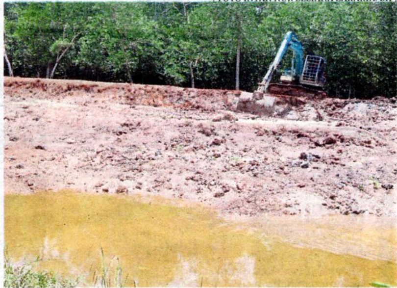
Jabatan Pengairan dan Saliran (JPS) Selangor memperbaiki ban yang pecah dan menyebabkan air laut membanjiri kampung di Kampung Tok Muda, Kapar.
