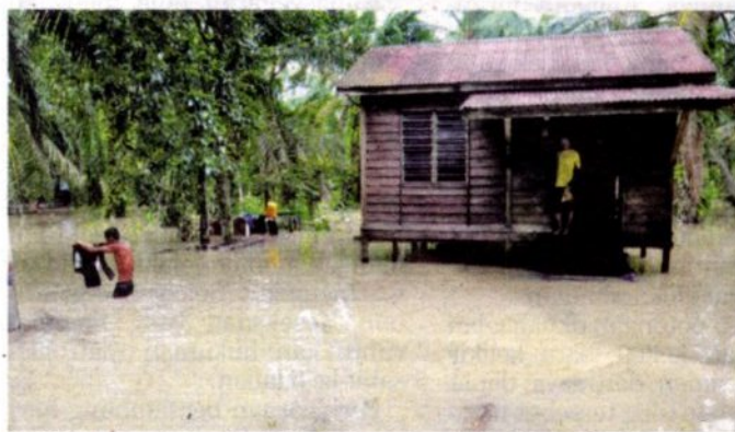
SEBUAH rumah yang terletak berhampiran laut ditenggelami air di Teluk Intan semalam.
