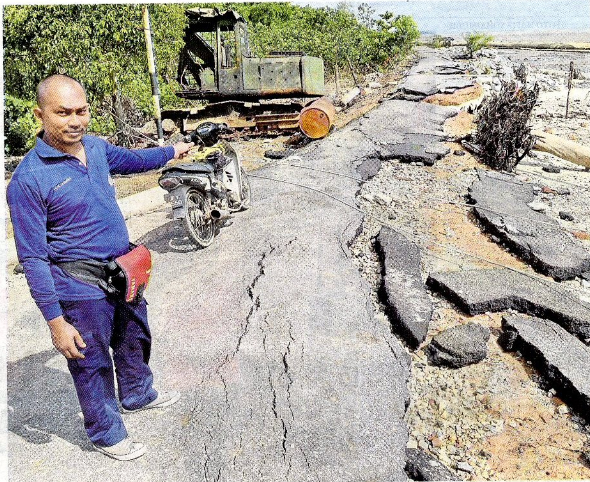
Pekerja Majlis Daerah Kuala Langat (MDKL), Mohd Shahrul Ismail, menunjukkan keadaan jalan tar yang turut musnah selepas dihakis arus deras berikutan fenomena air pasang besar, awal pagi semalam di Pantai Kelanang, Banting.
