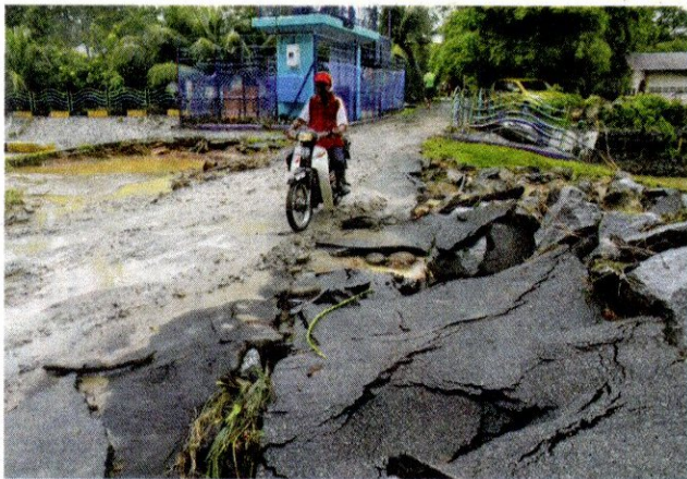
SEBATANG jalan raya dilihat rosak akibat banjir ketika tinjauan di Kampung Raga semalam.
