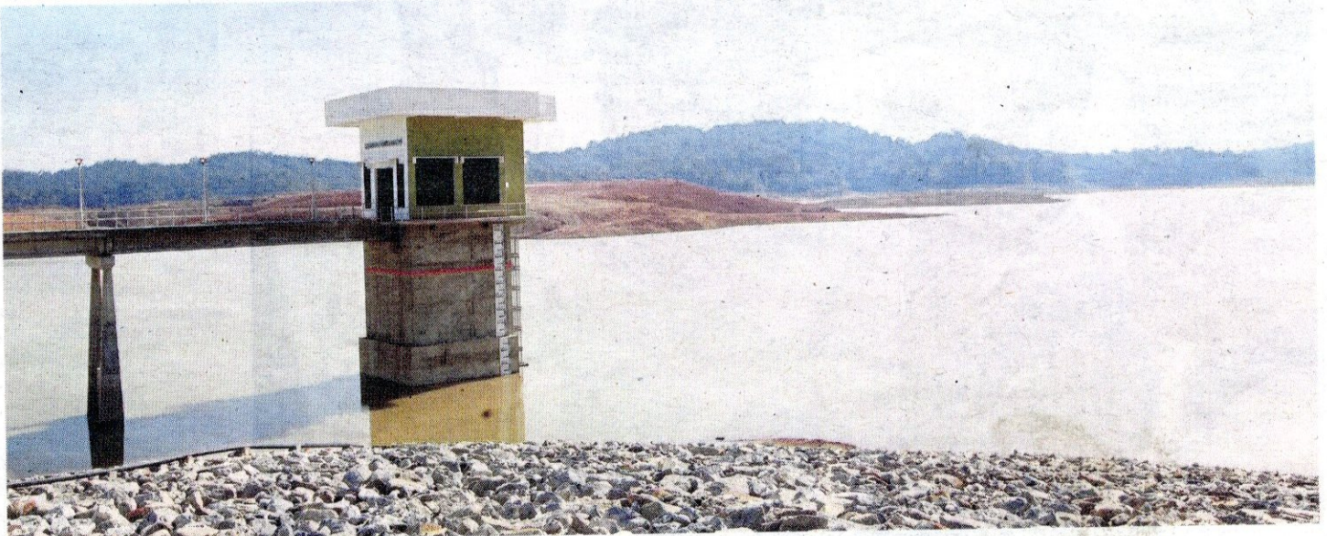
Projek Air Mentah Rapid di Empangan Seluyut, Kota Tinggi.
