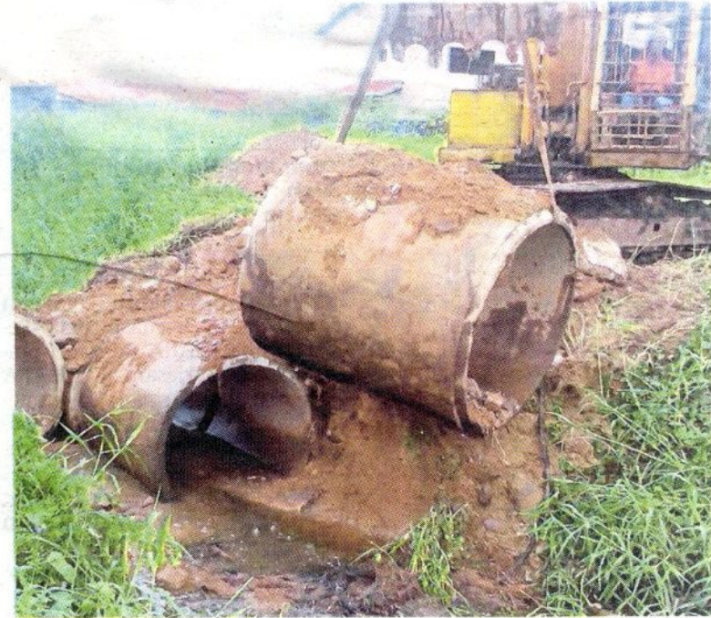
KERJA mengorek pembedung yang menjadi penghalang laluan air dilakukan.
