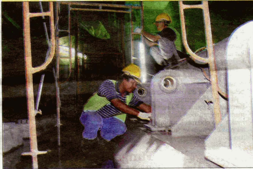
SALAH seorang pekerja sedang melakukan kerja-kerja dalaman di terowong SMART di Jalan Tun Razak, Kuala Lumpur.
