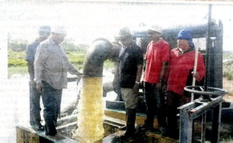
JPS memasang pam air sokongan bagi membekalkan air dari Terusan Sungai Ban Kanal untuk disalurkan ke dalam palung.
