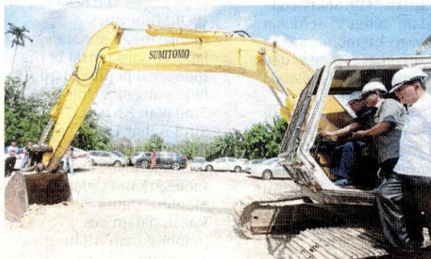
WAN Junaidi memandu jengkaut pada majlis pecah Tanah Projek RTB Muar pintasan Belemang di Kampung Belemang, Ledang.
