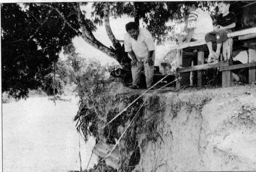
HAKISAN sungai membahayakan penduduk yang mempunyai rumah di tepi sungai di Hulu Langat, semalam.
