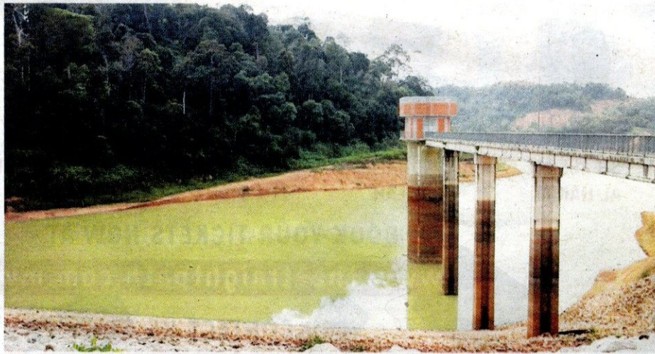
Empangan Gemencheh yang sudah mencapai paras kritikal.
