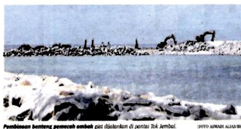
Pembinaan benteng pemecah ombak siap dijalankan di pantai Tok Jembal.
