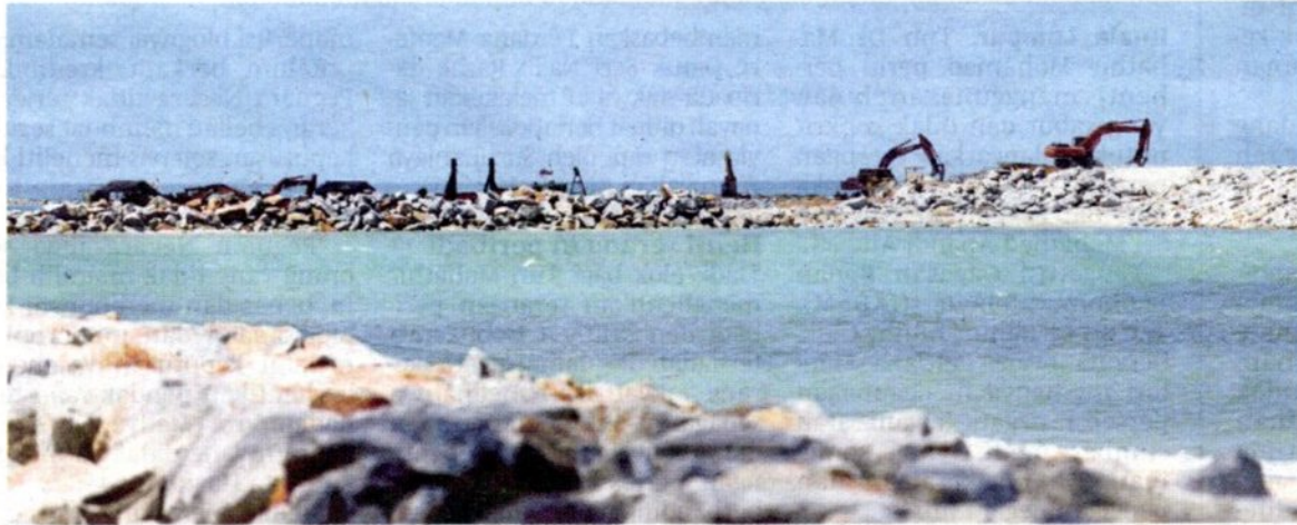
Pembinaan benteng pemecah ombak giat dijalankan di pantai Tok Jembal.
