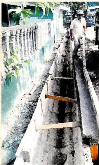
Kerja pembinaan longkang di Kampung Gombak Indah giat dijalankan.
