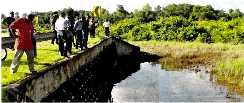
PENDUDUK bersama pegawai Jabatan Kerja Raya daerah Tumpat meninjau keadaan pintu air di Bendang Pak Yong, Tumpat semalam yang didakwa menyebabkan banjir di kampung di sekitar Sungai Golok, Pengkalan Kubor.
