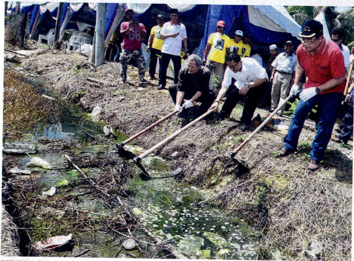
NOH OMAR (kanan) bersama Irmohizam Ibrahim (dua dari kanan) dan Mat Nadzari Ahmad Dahlan membersihkan parit semasa program G3K di Kampung Sungai Sembilang, Kuala Selangor, baru-baru ini.
