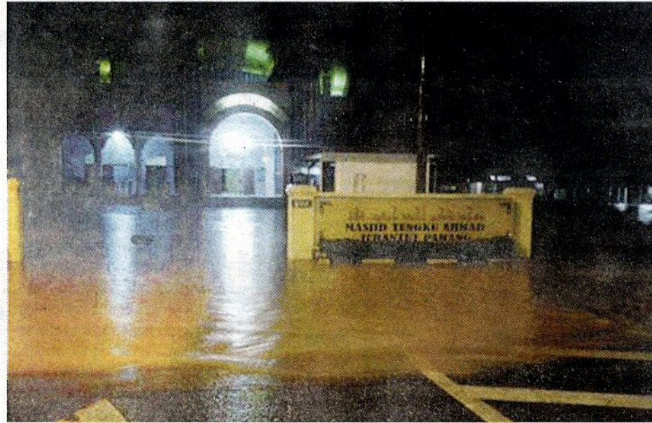
Pemandangan di hadapan Masjid Jamek Tengku Ahmad berdekatan laluan Benta ke Bandar Lama ditenggelami air sedalam satu meter.
