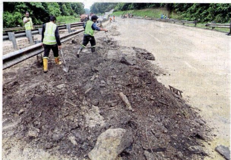
Kerja-kerja pembersihan jalan masih dijalankan di kawasan tanah runtuh.
