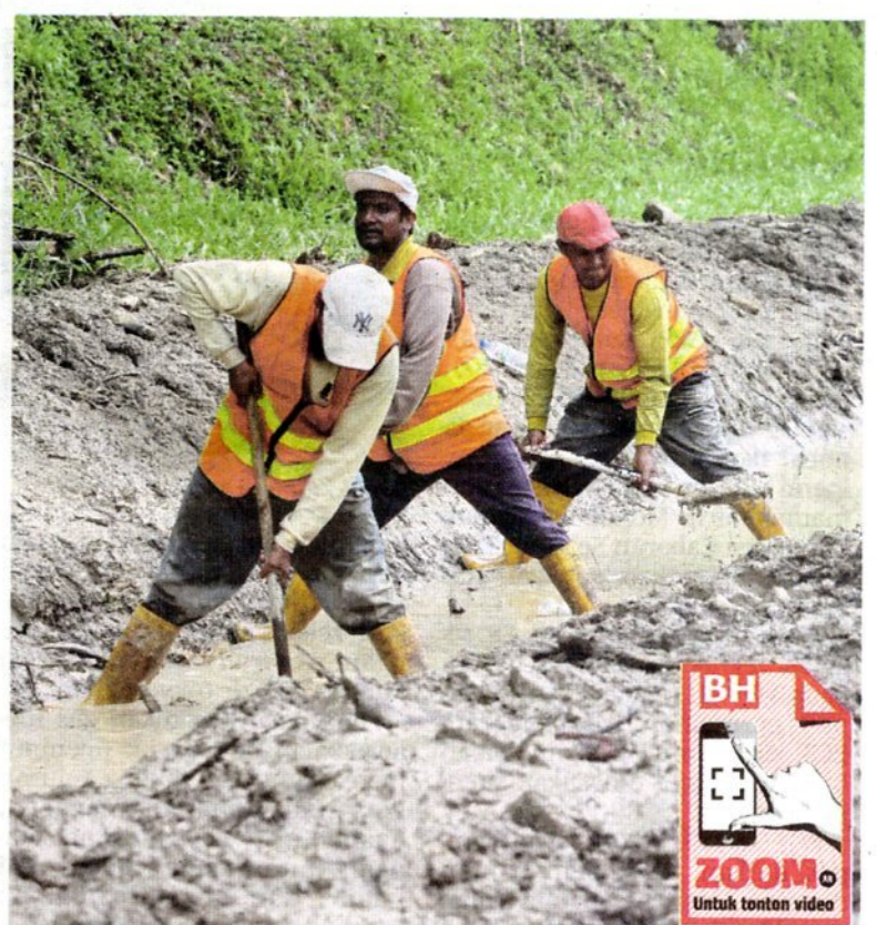
Pembersihan longkang dilakukan sebelum penghadang dipasang.
