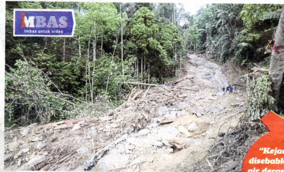
LOKASI kolam takungan air yang musnah dalam kejadian banjir.
