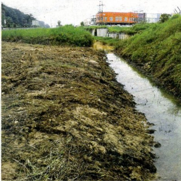
Kedadaan sistem saliran di sekitar Plaza Tol Bukit Beruntung yang menyebabkan kerap berlaku banjir kilat di kawasan itu.
