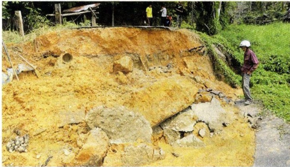
Jalan utama di Kampung Tepi Kolam mendap akibat tanah runtuh, menyebabkan lapan keluarga terputus hubungan sejak kelmarin.
