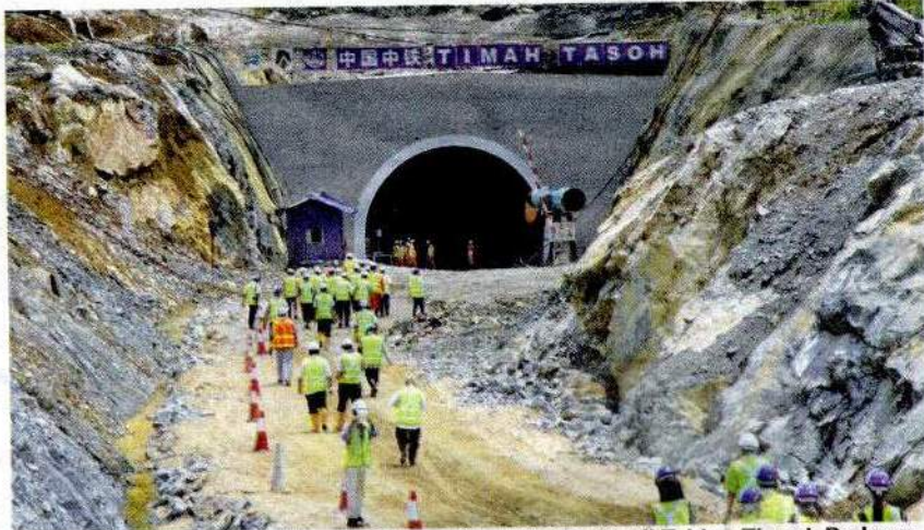
PEMBINAAN terowong laluan air sepanjang 756 meter di Tebing Tinggi, Padang Besar, Perlis ini hampir 70 peratus siap.
