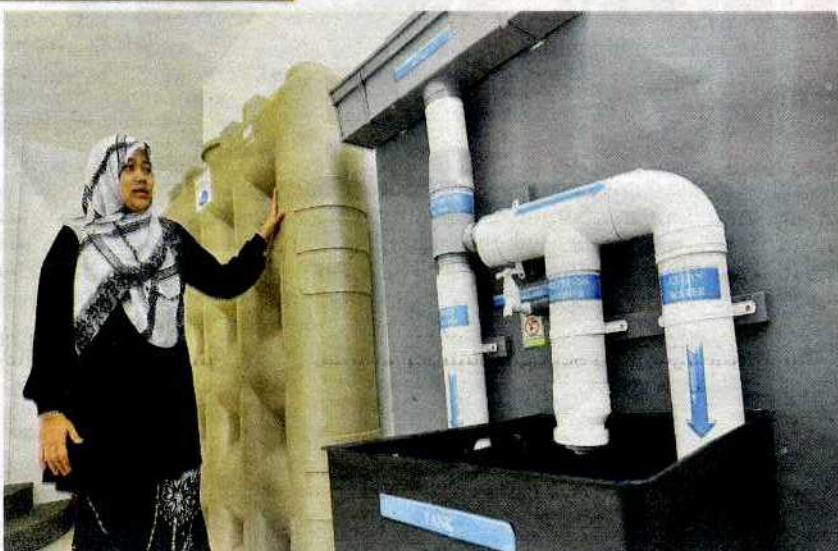
SISTEM asas penuaian air hujan mempunyai dua saringan tapisan.
