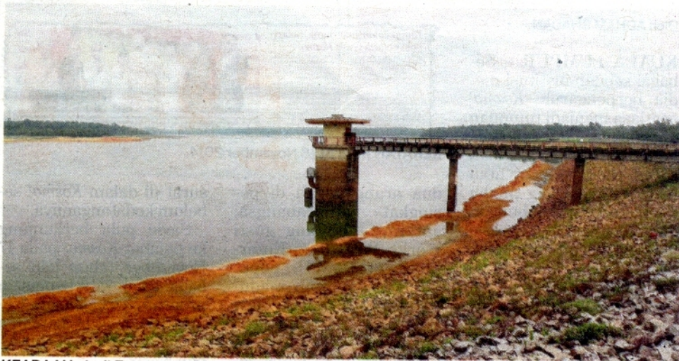
KEADAAN air di Empangan Sungai Layang. Masai yang berada di bawah paras normal menyebabkan catuan air terpaksa dilaksanakan sejak 16 Ogos lalu. – Gambar hiasan
