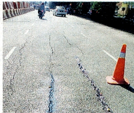
Keadaan permukaan Jalan Tun Razak yang retak kira-kira 50 meter.
