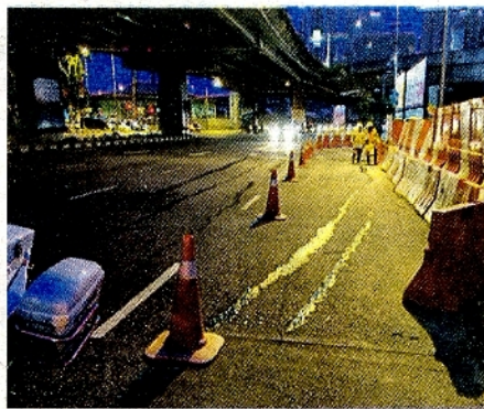
Pihak kontraktor meletakkan 'sealant' bagi menghalang air hujan masuk dan menjejaskan struktur jalan.
