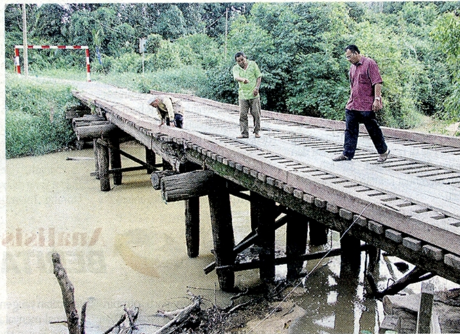
Abdul Razak (tengah) sedang memberi penjelasan mengenai keadaan jambatan sungai Keratong sambil Tuan Ibrahim (kiri) dan Andansura membuat tinjauan.
