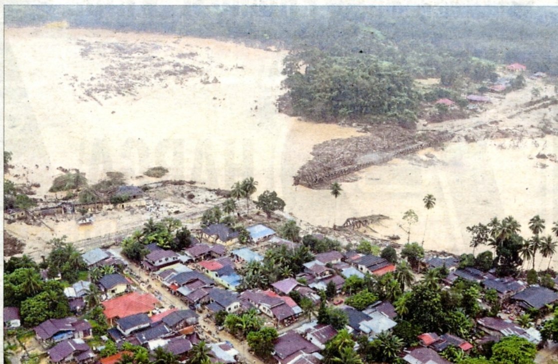
Jambatan kereta api menghubungkan Gua Musang - Kuala Krai yang runtuh pada hari kedua banjir di Kuala Krai.
