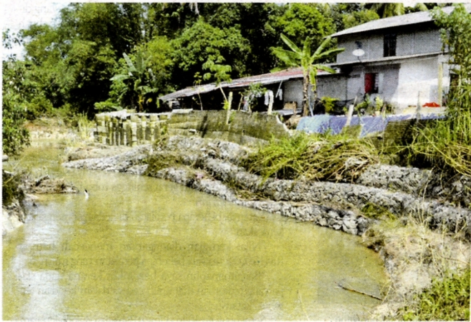
Benteng bakul batu yang dibina tidak memadai untuk menghalang terjahan arus sungai tahun 2012.
