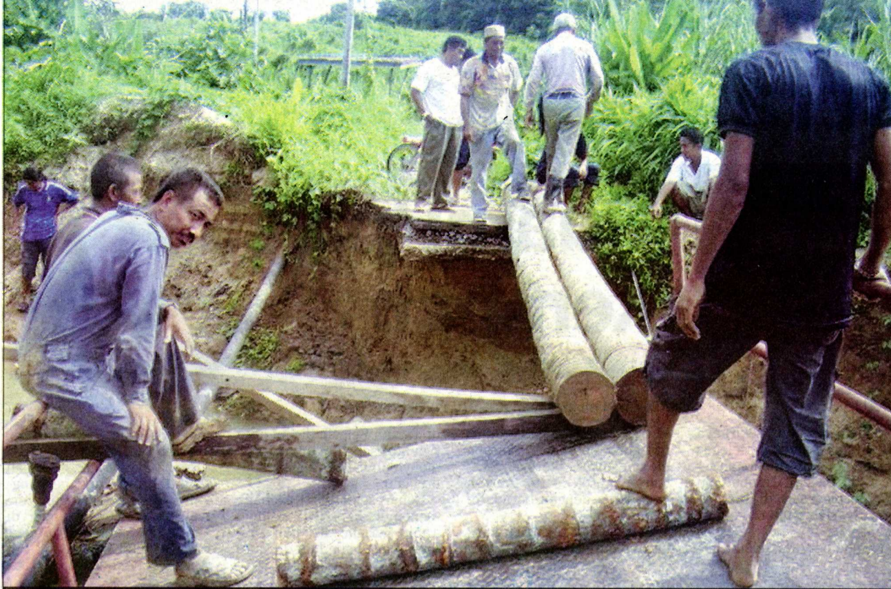
PENDUDUK kampung terpaksa membuat jambatan sementara dengan batang kelapa apabila jambatan di Sungai Nerok, Lenggong runtuh.
