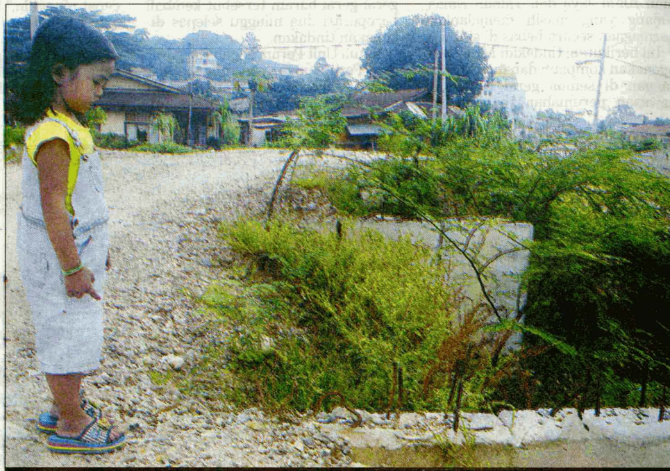
SEORANG kanak-kanak berdiri berhampiran projek meluruskan Sungai Gombak yang terbengkalai di Kampung Kunci Air, Simpang Tiga, Gombak semalam.
