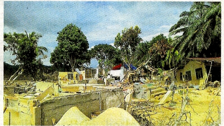
Empat rumah yang terletak di tebing Sungai Kelantan antara yang hanyut dalam kejadian banjir besar melanda Kampung Dusun Nyiur.
