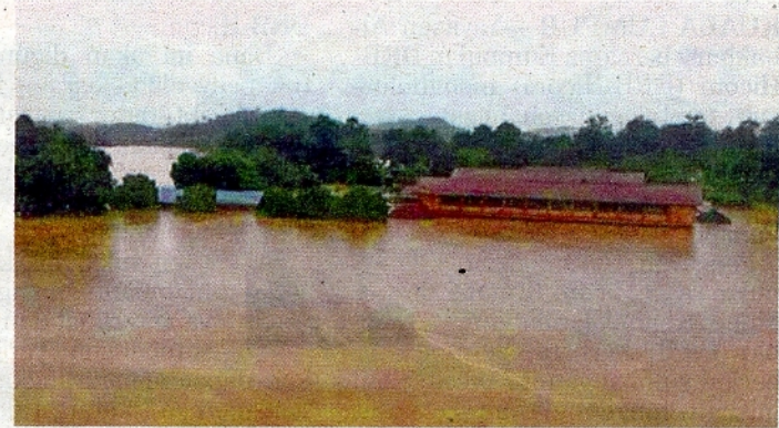
KEADAAN Sekolah Menengah Kebangsaan Manek Urai di Kuala Krai yang ditenggelami air sehingga paras tingkat tiga bangunan itu dalam kejadian banjir besar baru-baru ini.
