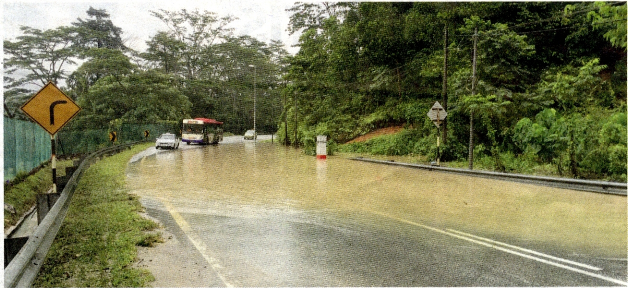
Kesan banjir lumpur di jalan menghala ke Kampung Sungai Pusu.
