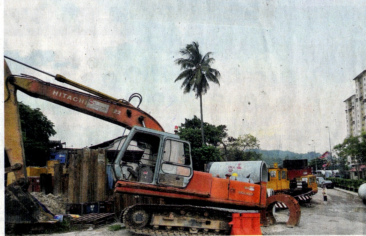
JENTERA berat bagi kerja-kerja pembinaan longkang yang diletakkan berhampiran PPR Seri Anggerik, Jalan Klang Lama, Kuala Lumpur didakwa turut mengundang rasa tidak selesa penduduk.
