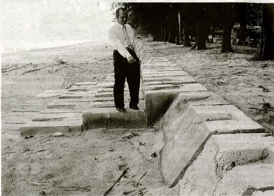
BENTENG...Lim menunjukkan benteng di Pantai Irama, Bachok ketika pembinaan, baru-baru ini.
