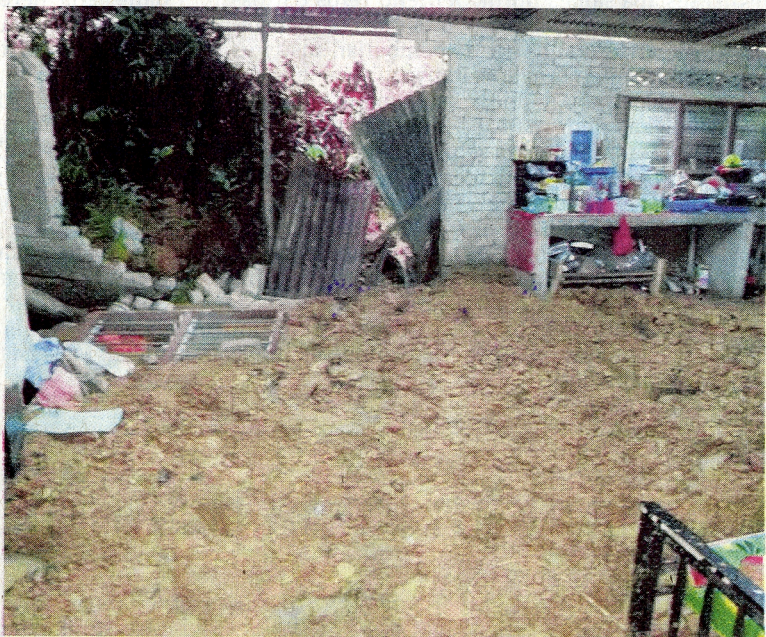
SEBUAH rumah yang dilanda tanah runtuh akibat banjir kilat di PPRT Sungai Sia, Raub, Pahang, kelmarin.
