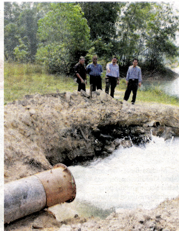
Pengepaman air dari Lombong Kampung Hang Tuah ke muka sauk Sungai Selangor tidak berbahaya kerana ia kawasan paya gambut.
